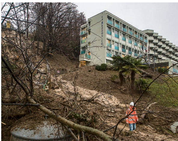
Lo smottamento ha sfiorato l'istituto Ca' Rezzonico. TIPRESS
